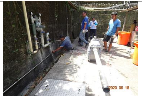
天然氣管線施工
