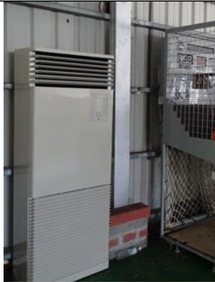
活動中心冷氣機裝設完成
