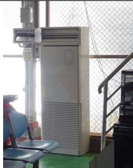
活動中心冷氣機裝設完成
