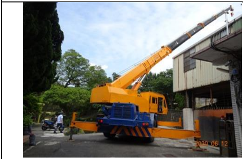
天然氣管線施工
