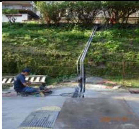
水塔電纜地下化，以保護水塔電源纜線安全及環境美觀
