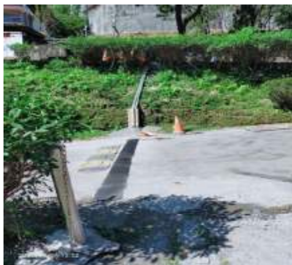
水塔電纜地下化，以保護水塔電源纜線安全及環境美觀
