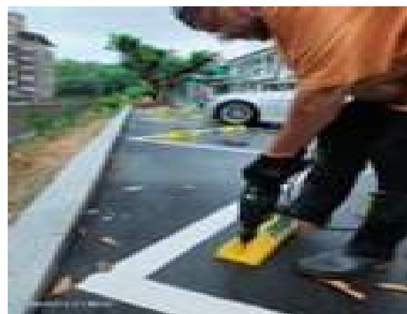
安裝汽車停車格車擋，以利洽公民眾或同仁停車時，感知車頭停止底線
