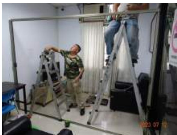
整修遠距接見室，裝設拉簾隔間，讓申辦遠距接見的民眾不受打擾而有隱私感
