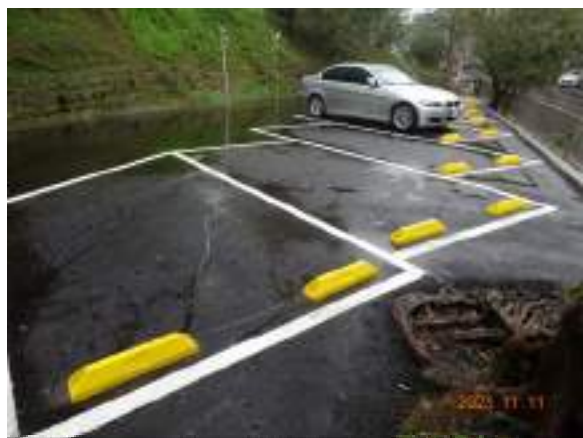
安裝汽車停車格車擋，以利洽公民眾或同仁停車時，感知車頭停止底線
