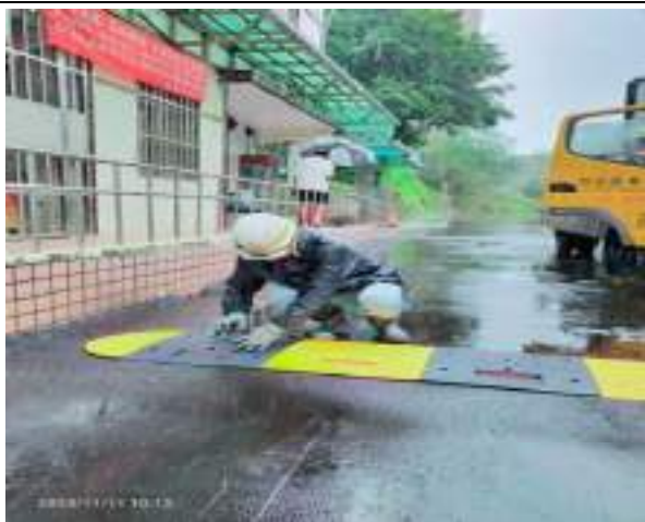
安裝跳動路面減速帶，避免車輛行經門衛管制處車速過快，以保障行人安全
